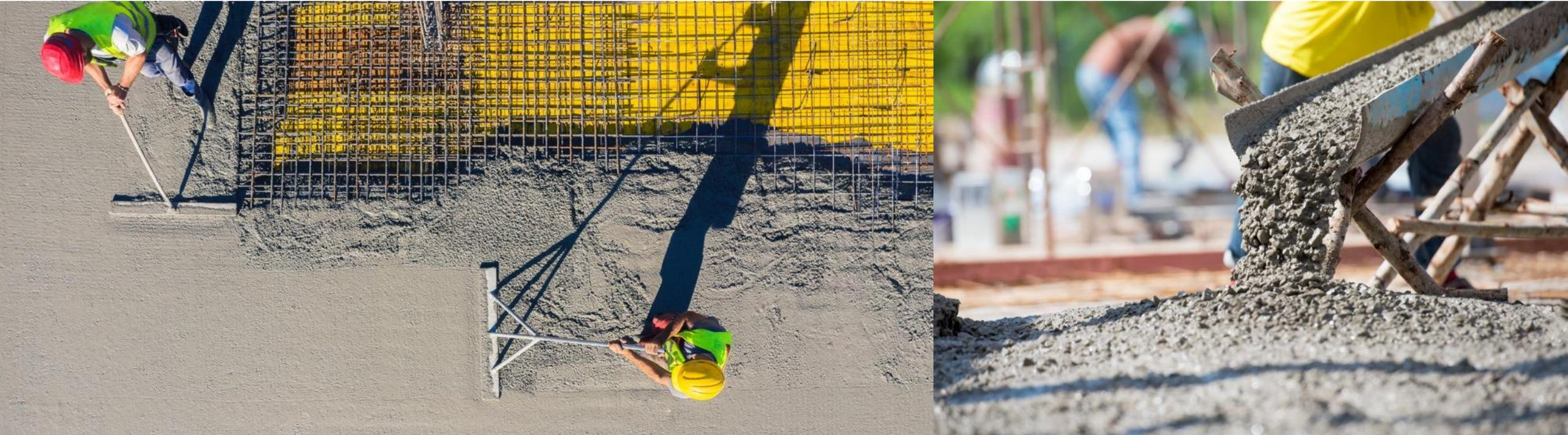
Les pouzzolanes naturelles 3M™, un sous-produit de la production des granulés de toiture 3M, peuvent être utilisées comme matériau de ciment supplémentaire (SCM) pour fabriquer du béton. **L'utilisation de ce matériau permet de réduire les émissions de CO2 en remplacement partiel du ciment dans le béton.** On estime que chaque tonne de SCM utilisée pour remplacer le ciment réduit les émissions de CO2 de 0,75 tonne et peut aider à obtenir des crédits LEED pour l'utilisation de matériaux recyclés
