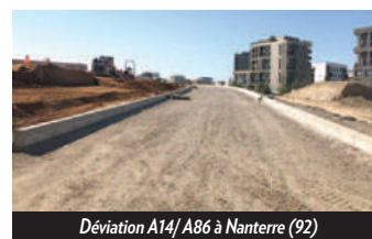
Déviation A14/ A86 à Nanterre (92)
