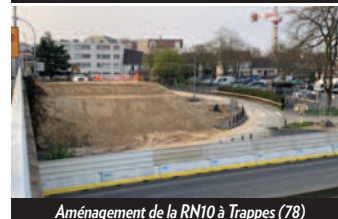
Aménagement de la RN10 à Trappes (78)
